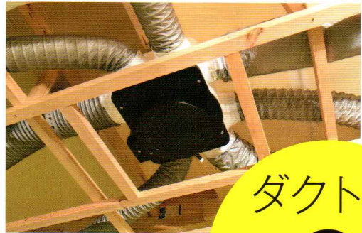
ダクト式第3種換気システム (ルフロ)
