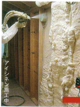
▼アイシネン施工の様子
