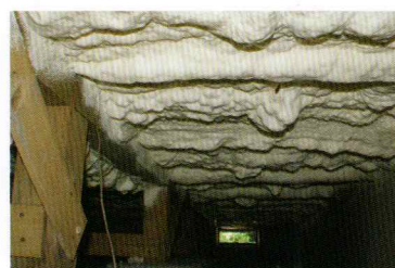
床下に隙間なく吹付けられた アイシネン
