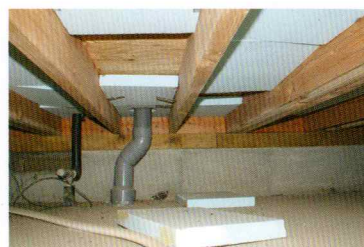
脱落したボード系断熱材
